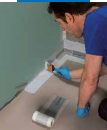
Postavljanje Mapeband PE 120 trake upotrebom Mapegum-a WPS
