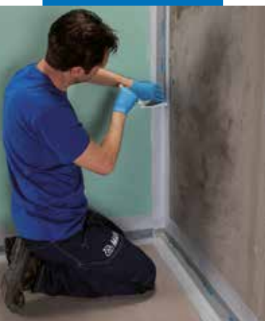
Postavljanje Mapeband PE 120 trake upotrebom Mapegum-a WPS
