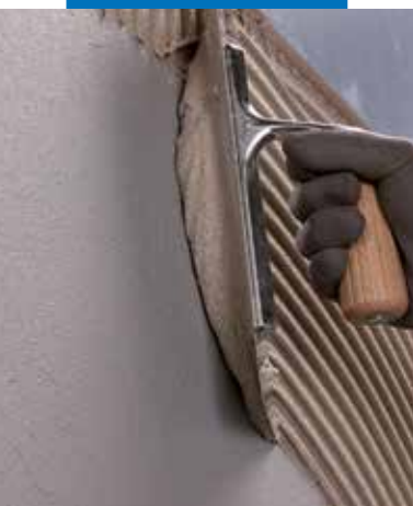
Postavljanje podnih obloga koristeći Ultramastic III
