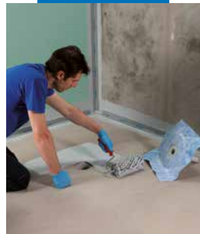
Postavljanje vertikalnog odvoda upotrebom Mapegum-a WPS
