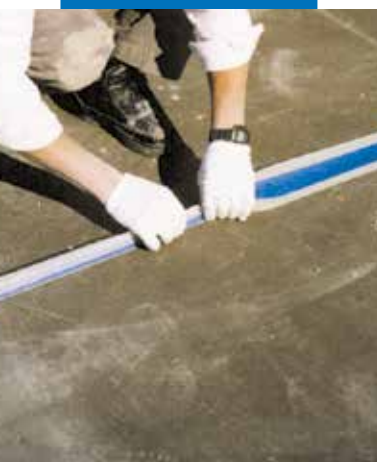
Primer zaptivanja dilatacionih spojeva na terasi
